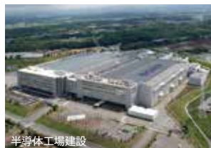
半導体工場建設
